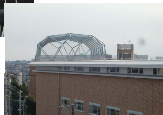
体育館側から見た校舎屋上の防球フェンス
