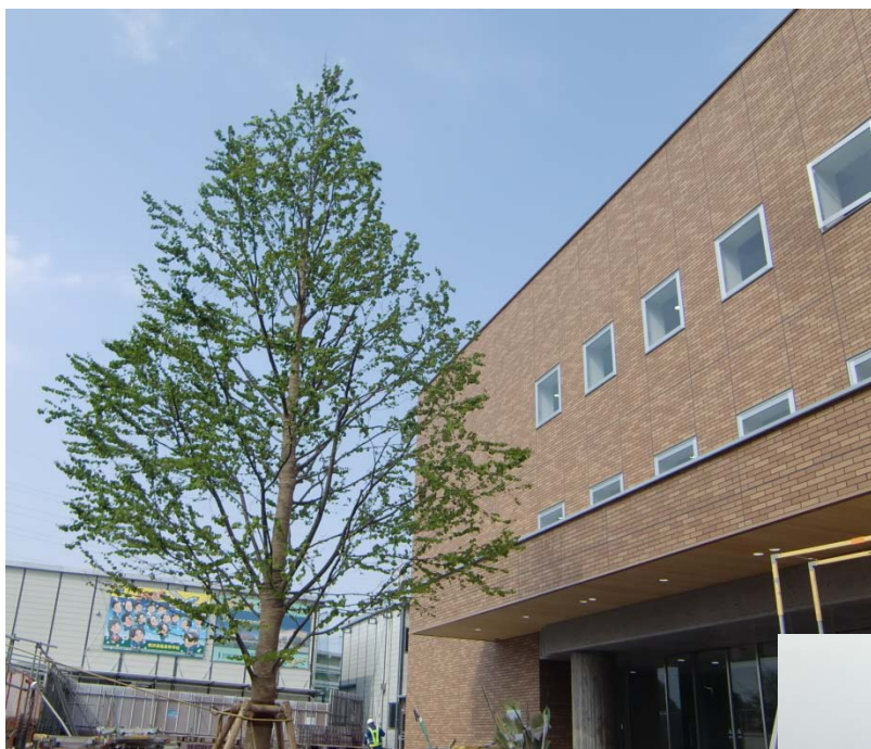
体育館エントランスに植樹された シンボルツリー（桂の木）
