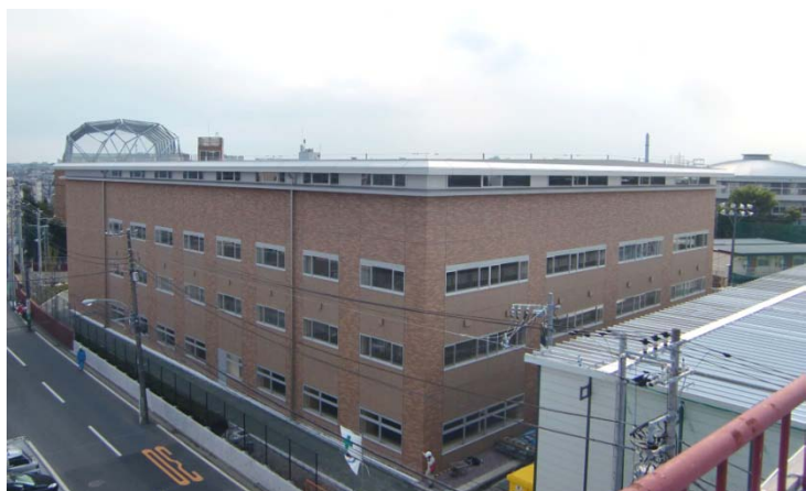
完成間近の体育館全景
